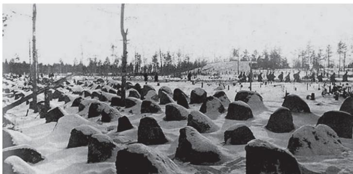
Бетонные противотанковые надолбы
